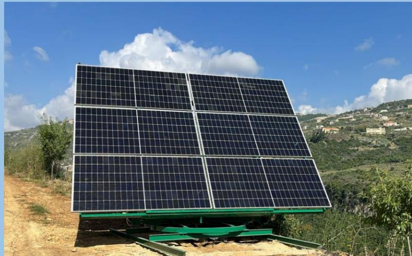
Un tracker solaire innovant qui **suit les mouvements du soleil** de la journée. Grâce à cette fonction Hélios PV optimise la capture des radiations solaires, ce qui permet **d'augmenter la production de 25% à 35%** par rapport à un système fixe classique. Hélios PV est donc un système haute performance low-cost pour produire de l'énergie électrique à partir du soleil.
